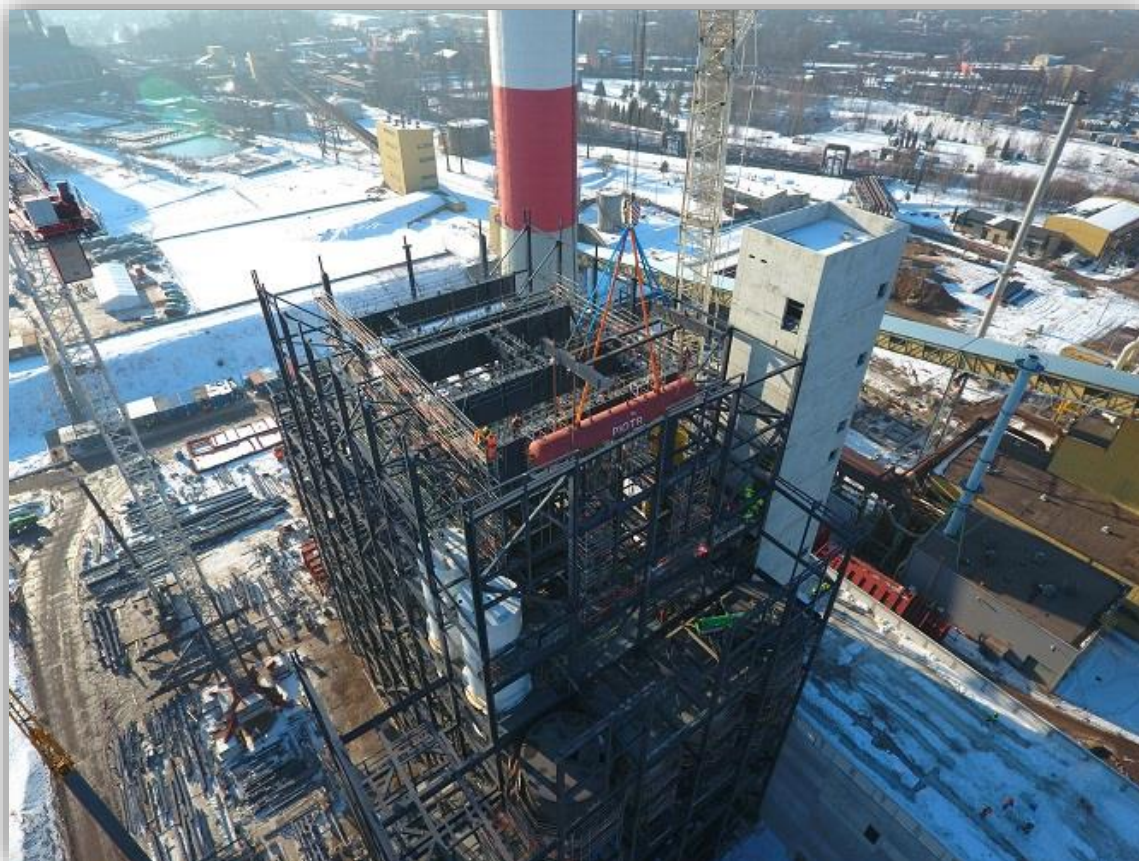
Stan budowy na 24.01.2017 r.
